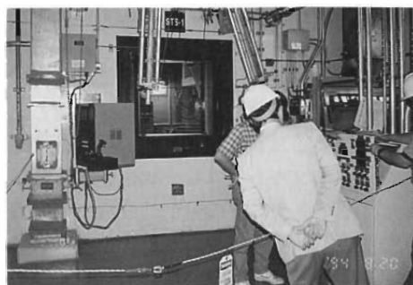
写真1 見学中のDWPF施設
