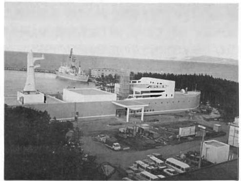
むつ科学技術館（仮称）建設工事状況 （建屋屋上の排気塔は、本船から移設したものです）
